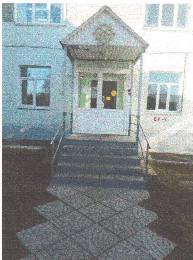
№ 2.1. Вход в здании ДОУ.
